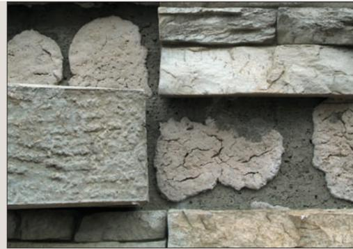
**8. FALSCHER PUNKTFÖRMIGER VERLEGER AUF STAHLBETON**, im Winter bei Temperaturen der Mauer bei 0°C oder darunter und in Gegenwart von **Wasserschleier** verursacht durch Reinigung des Untergrunds mit Hochdruckwasserstrahlmaschine, ohne die Trocknung abzuwarten. Dasselbe Problem kann sich bei **Schaltrennmitteln, abdichtenden Behandlungen oder Haftmitteln mit Filmbildung** ergeben. Es fehlt die doppelte Kleberspachtelung, auf Stück und Untergrund, für eine Frisch-in-Frisch-Verlegung.
