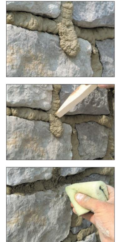
Eventuell noch frische Läuferbildungen am Stein nicht säubern, sondern erst nach kurzem Eintrocknen entfernen: überschüssigen Fugenmasse mit einem Holzstäbchen entfernen und sodann den verbleibenden Rand mit einem nassen Schwamm säubern. Nur den betroffenen Bereich behandeln.
