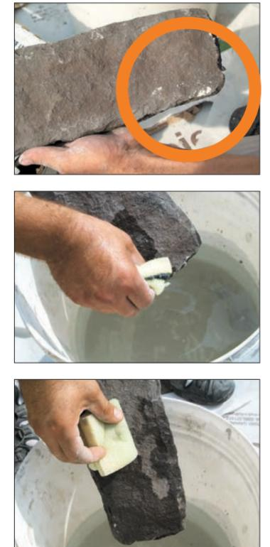
Während der Verlegung darf der Stein auf keinen Fall mit Geocoll® beschmutzt werden. Immer mit sauberen Händen arbeiten. Eventuelle Klebstoffflecken sind umgehend mit einem sauberen Schwamm und Wasser zu entfernen. Bei der Reinigung des verlegten Steins darf nur auf den betreffenden Bereich eingewirkt werden.
