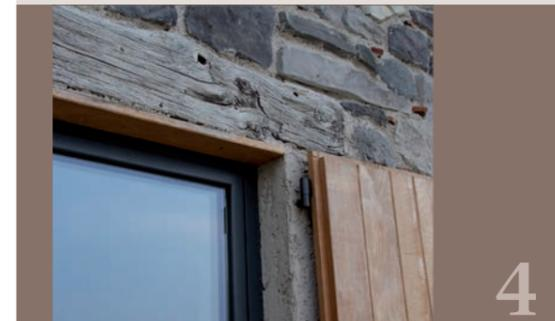
Der einfache Einsatz eines Dekorbalkens stellt, wenn auch nur optisch, das Bedürfnis nach einer Abstützung der über der Tür- und Fensteröffnung liegenden Mauer zufrieden und verleiht dem Ganzen Glaubhaftigkeit. Einen 5/6 cm dick zugesägten Balken an der Öffnung oben anbringen und den Rest der Umrandung mit Isoliermaterial verkleiden. Für die Befestigung von Angelzapfen für evtl. Fensterflügel spezielle Halterungen vorsehen, die vor der Verlegung des Wärmedämm-Verbundsystems montiert werden.
