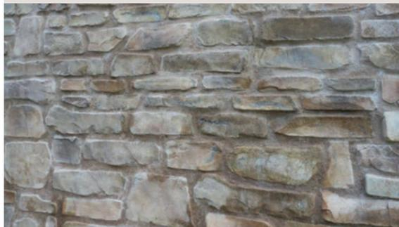
Auf den Bildern dieser Seite hat der Mangel nach angemessener Abdichtung zu Wasserinfiltrationen an Wand und zur Bildung von Salpeter geführt. Das hat nach einigen Jahren die Beschädigung der Steinoberfläche verursacht.
