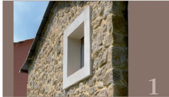
Bei verputzten Ausführungen von Tür- und Fensteröffnungen muss ein circa 6 cm dicker Rahmen vorgesehen werden, um die Steindicke zu verdecken. Bei der Fertigung dieses Rahmens können Abfallreste von Isoliermaterial verwendet werden, die mit einem geeigneten Kleber an das Wärmedämm-Verbundsystem geklebt werden. Anschließend wird verspachtelt und das Armierungsnetz eingebettet. Den Rahmen mit farbigem Oberputz verkleiden.
