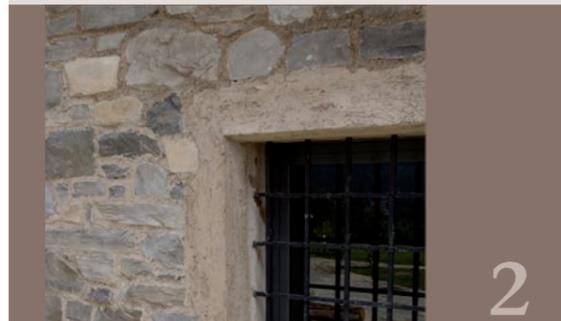
Für flächenbündig gespachtelte Steinleibungen die Fensterumrandung mit Isoliermaterial verkleiden. Anschließend mit dem Cutter den Rahmen so einstechen, dass der eingefügte Stein, nachdem er mit Mörtel verputzt wurde, flächenbündig versenkt ist. An der so erzielten Kante können die Angelzapfen für die Fensterflügel befestigt werden, nachdem vor der Verlegung des Wärmedämm-Verbundsystems die spezifischen Montagehalterungen vorgesehen wurden.
