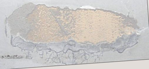
**3. FALSCHER VERLEGUNG AUF LOCHSTEIN IM AUßENBEREICH.** Die Gebäude, die dem Unwetter ausgesetzt sind, werden normalerweise mit absorbierendem Material nicht durchgeführt. Auf dem Bild ist die Folge einer Verkleidung zu sehen, wo die Verlegung auf einem Untergrund aus Vollstein/ Ziegeln im Außenbereich erfolgte.
