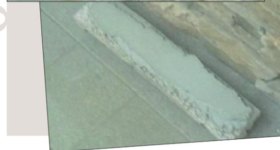
**4. FALSCHER VERLEGUNG AUF FRISCHER SPACHELUNG.** Die Verlegung auf Gipskarton mit frischer und nicht gehärteter Spachtelung von Kleber hat zur vollständigen Loslösung von Stein und Kleber geführt. Wenn auf dem Untergrund Kleber gespachtelt wird, um ihn zu stabilisieren, darf die Verkleidung erst angeklebt werden, wenn der Aufstrich komplett getrocknet ist.
